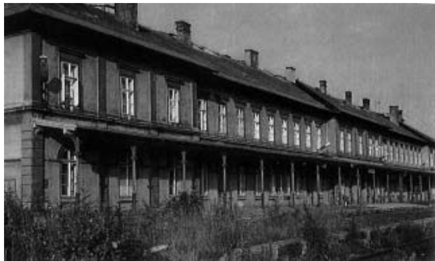
Nádraží v Moldavě v Krušných horách, součást kulturní památky Moldavská horská dráha
