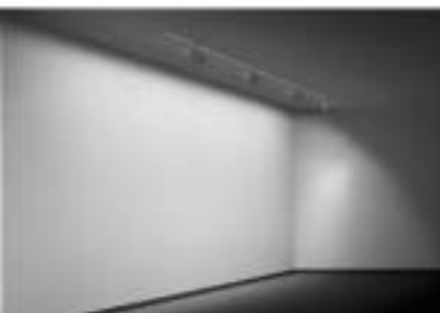
Světlomety a lištové systémy – asymetrická vyzařovací charakteristika „wallwasher“ – rovnoměrné nasvícení celé stěny s exponáty
