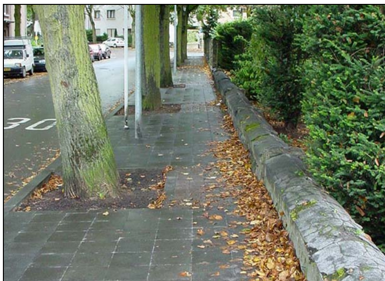
Photo 013 > Les éléments non alignés et non placés au bord du trottoir peuvent être une cause d'accident ou de désorientation pour les personnes malvoyantes.
