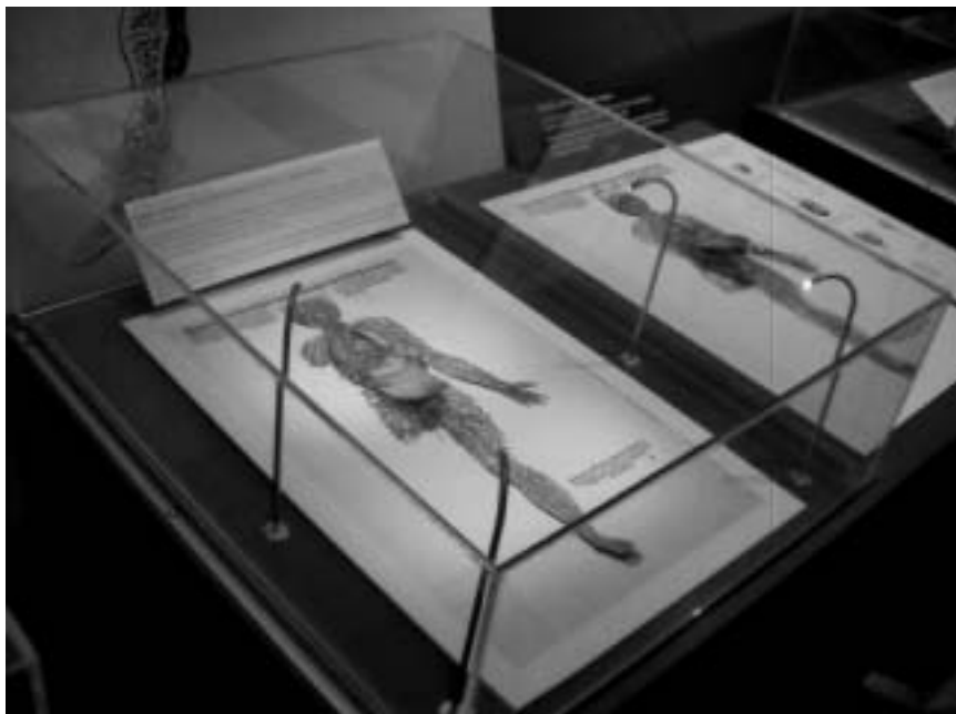
Vhodné osvětlení vitrín pomocí bodových světel (Huntington Library, USA)
