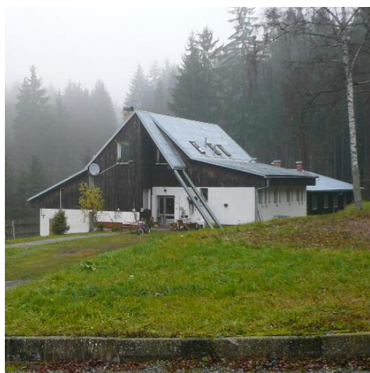
Fotografie č. 5: Barák dozorců se zděnou přístavbou, stav v roce 2010. Archiv NPMK.
