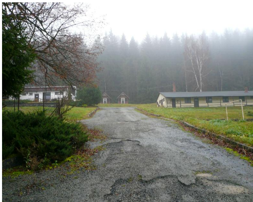
Fotografie č. 4: Stav tábora Hodonín před zahájením stavebních prací, vpravo barák vězňů 2010. Archiv NPMK.
