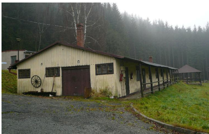
Fotografie č. 6: Barák vězňů, stav v roce 2010. Archiv NPMK.
