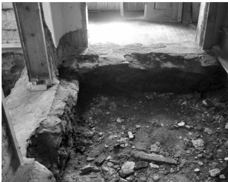
Obr. 3: Sanace chodby, foto: B. Švecová.
