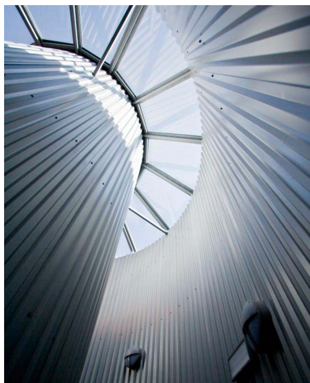
Obr. 4: Bezbariérový přístup – výtahová šachta – pohled zevnitř.
