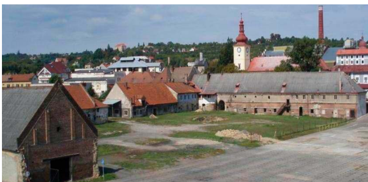
Obr. 2: Areál bývalého hospodářského dvora – před rekonstrukcí.
