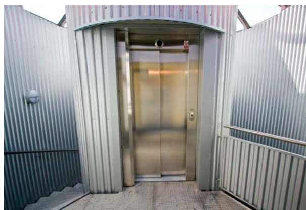
Obr. 5: Bezbariérový přístup – výtahová šachta – pohled zevnitř.
