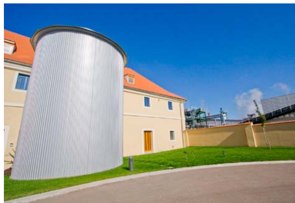
Obr. 3: Bezbariérový přístup – výtahová šachta – pohled z venku.
