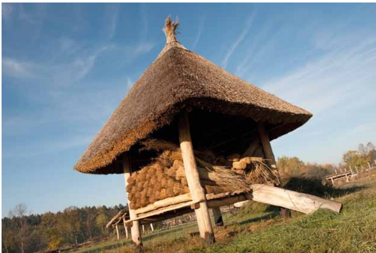
Obr. 26: Nadzemní sýpka (rozestavěná).
