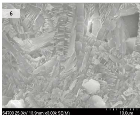
Obr. 6: Krystaly síranu vápenatého tvořící krustu na několika skleněných dílcích vitráže (snímek z elektronového mikroskopu vzorku č. 6).
